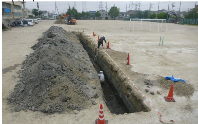
トレンチ掘削状況(トレンチ
