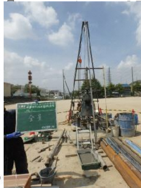
ボーリング状況
