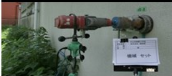
①コンクリート壁のコア抜き
