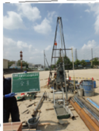
ボーリング状況
