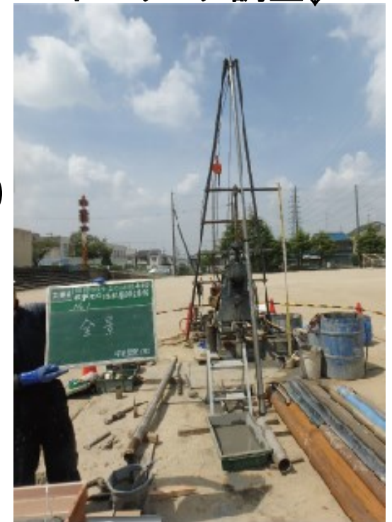
ボーリング調査↓
