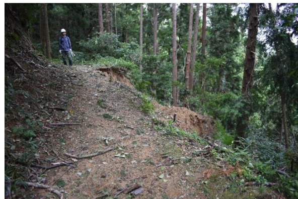
平成30年の台風21号 曲輪法面の崩壊
