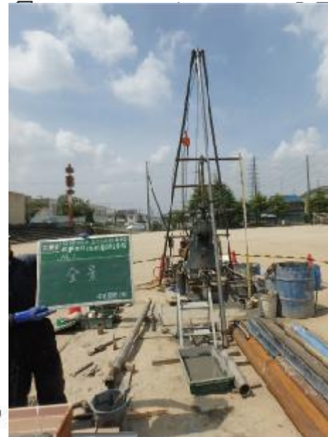
ボーリング状況
