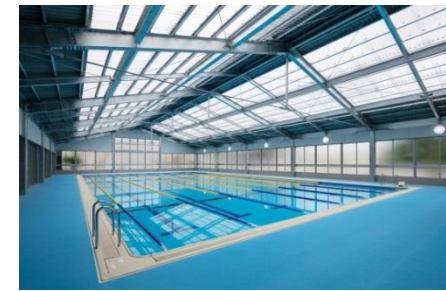
プール棟新築（西中学校）
