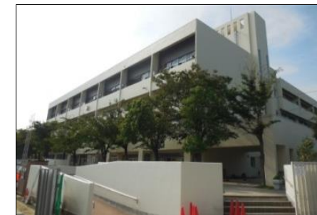
四條畷西中学校校舎大規模改修
