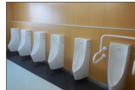
四條畷中学校校舎内トイレ改修
