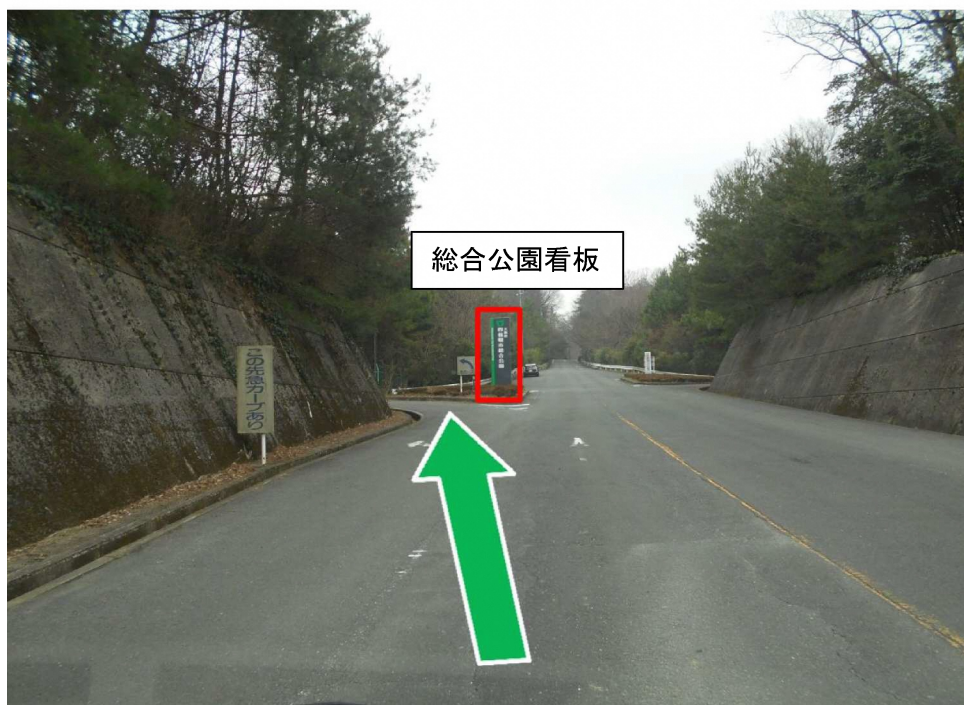
⑪ 信貴・生駒スカイラインを 四條畷市総合公園入口へ 車線変更し入場
